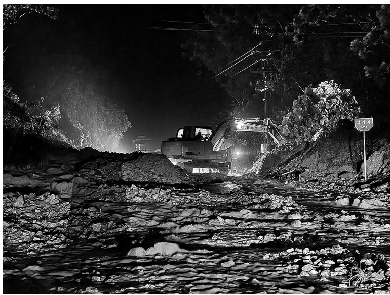
北流公路养护中心工作人员在抢修国道359线佛山至富宁公路玉林北流市石窝镇塌方路段。(卢晰 摄)
