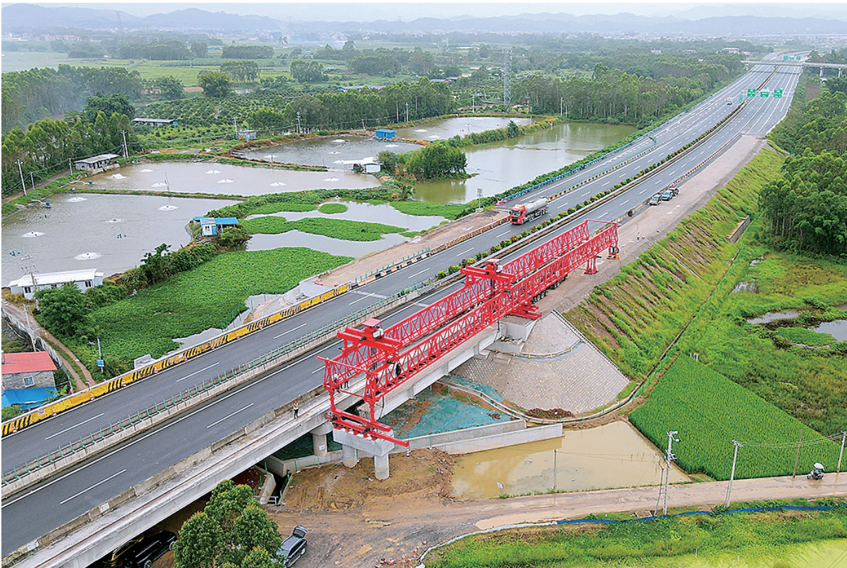
岑大公路荔玉路共线段扩容工程首片预制T梁架设现场。(本报记者 蒋金泰 摄)
