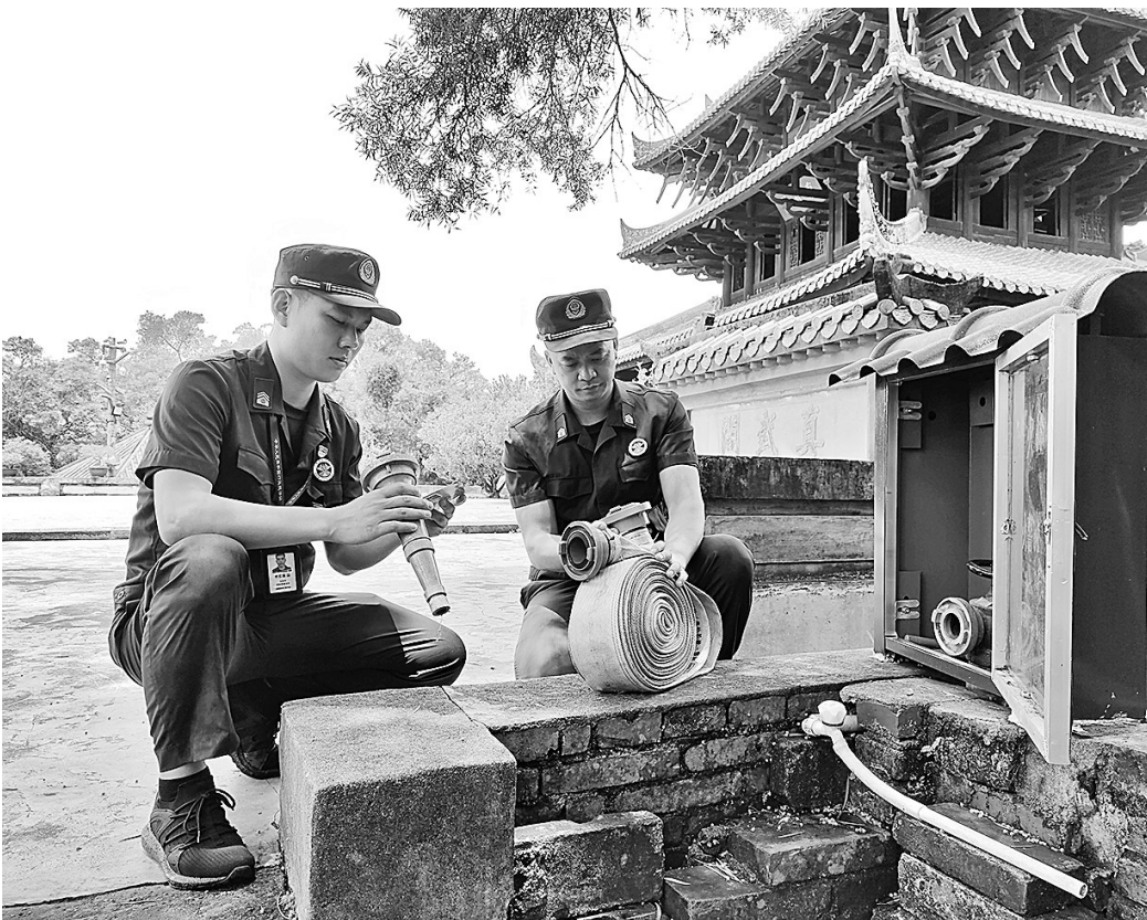
消防人员在真武阁检查消防设施。
