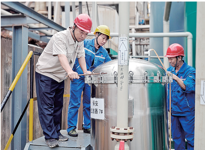
杨四文(左一)带领工友们更换滤袋、清洗设备。
