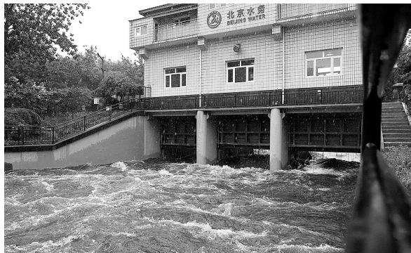
这是7月30日拍摄的凉水河分洪道闸。(新华社记者 张晨霖 摄)
