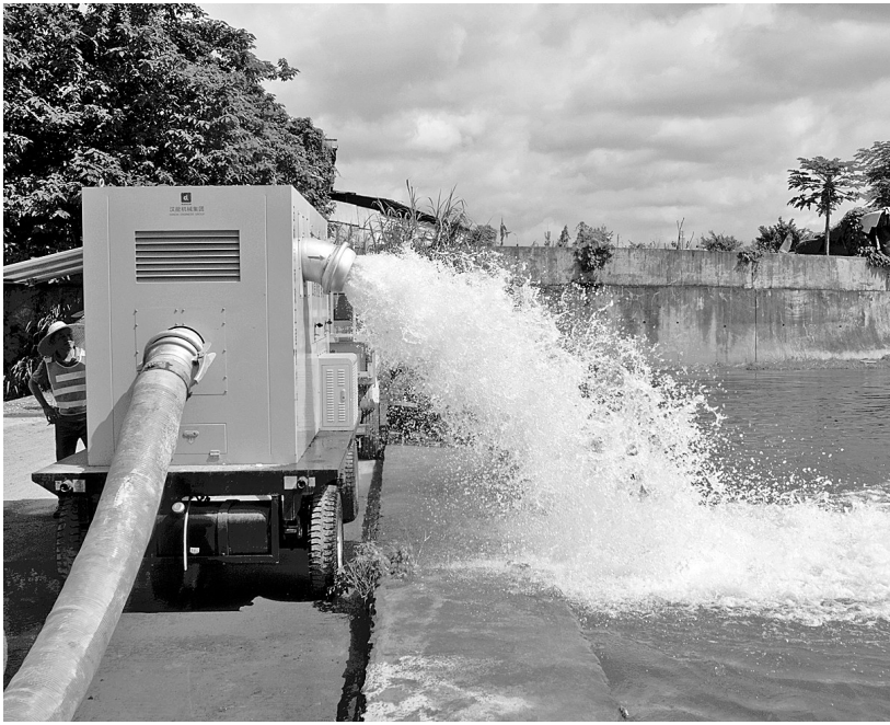
演练人员用移动抽水机抽排水。
