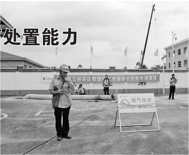
抢险人员在对现场燃气浓度进行检测。
