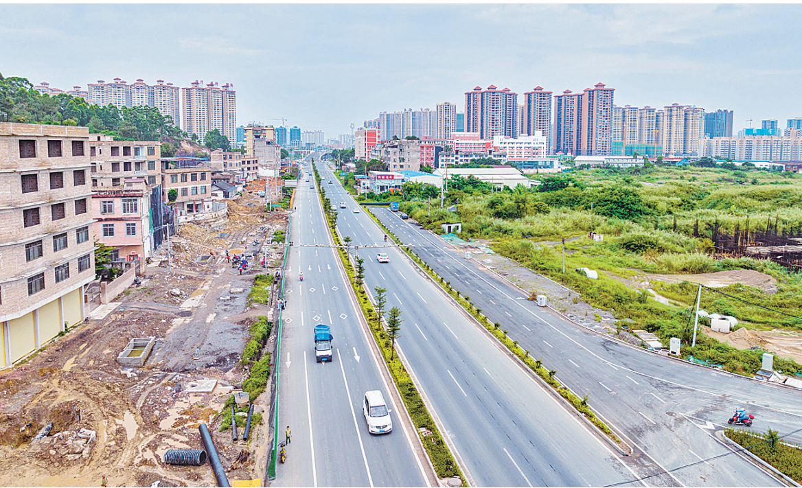
正在建设中的民主南路(市政段)。
